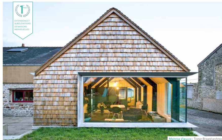
Maitrise d'œuvre : Tristan Brisard architecte.
